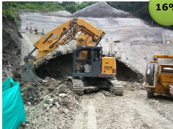
Se adelanta: Construcción del portal de entrada al túnel y estabilización del terreno.
