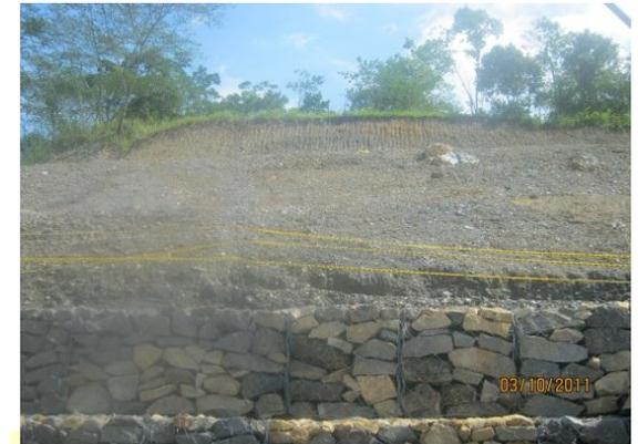
Se adelanta: construcción de muros de contención, movimiento de deslizamientos y pilotaje
