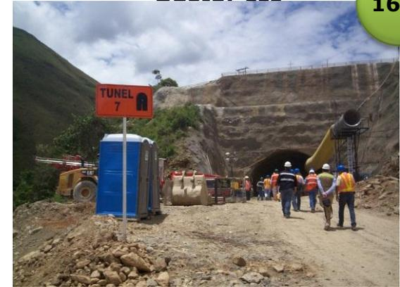
Se adelanta: Excavación de 40 metros de túnel, con instalación de pernos, arcos y concreto lanzado.
