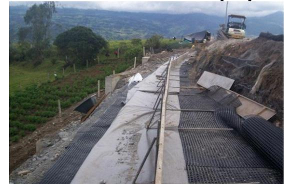
Entregado: Construcción de muro de contención sobre 32 caissons, en atención al hundimiento de banca presentado.
