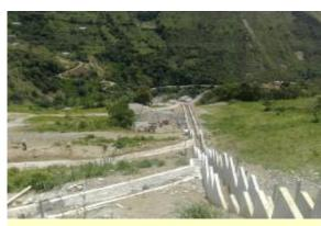
Estabilización del sector Puente Quetame – Caño Seco, construcción de estructuras de drenaje.
