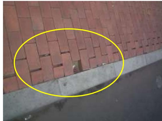
En esta obra se identificaron puntos con fallas y hundimientos en los adoquines, por lo cual se advirtió que en el corto plazo esto podría causar un daño en toda la obra. En una visita posterior se verificó que estos puntos fueron arreglados.
