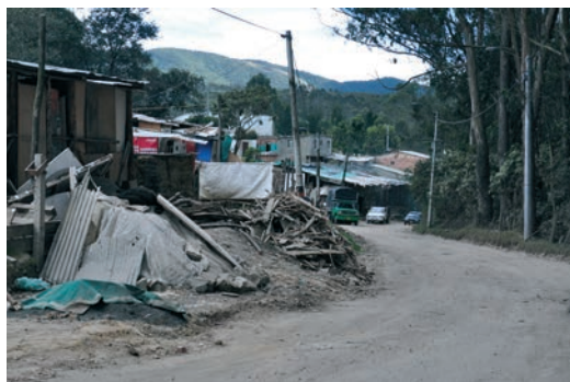
Figura 56. Vía a La Calera - Sector Lomitas, Localidad de Usaquén
