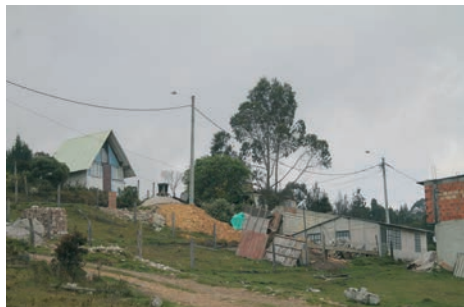
Figura 41. San Isidro - Patios, Localidad de Chapinero
