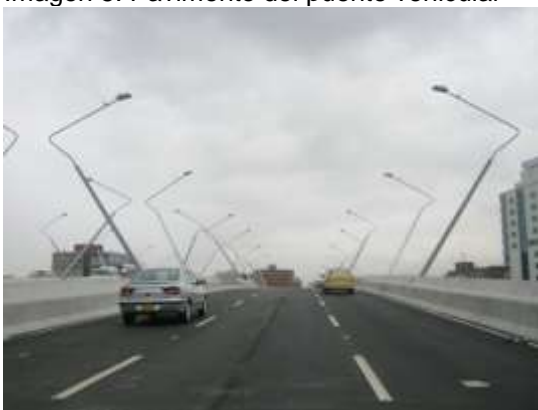
Imagen 5. Pavimento del puente vehicular
