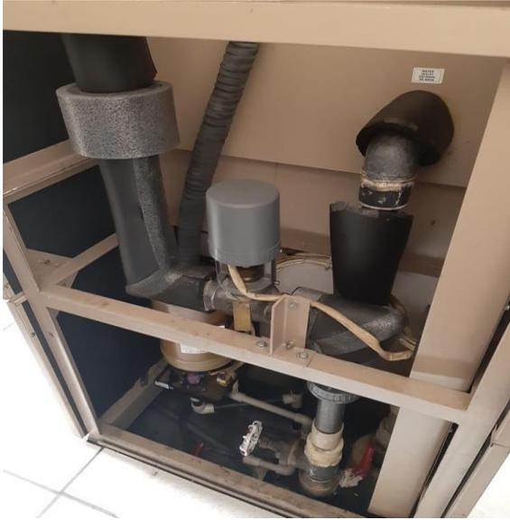
ILUSTRACIÓN 3 TUBERÍA UNIDAD MANEJADORA
