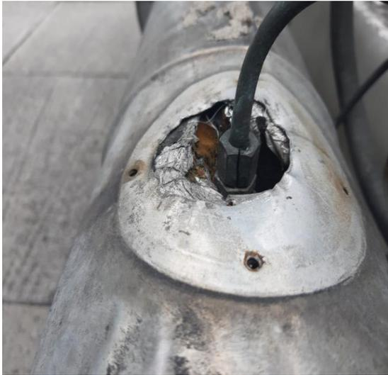
ILUSTRACIÓN 7 VÁLVULA FLARE EN MAL ESTADO
