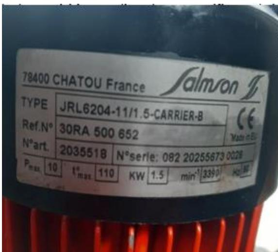
ILUSTRACIÓN 5 REFERENCIA MOTOR ELÉCTRICO DE CHILLER 1 Y 2
